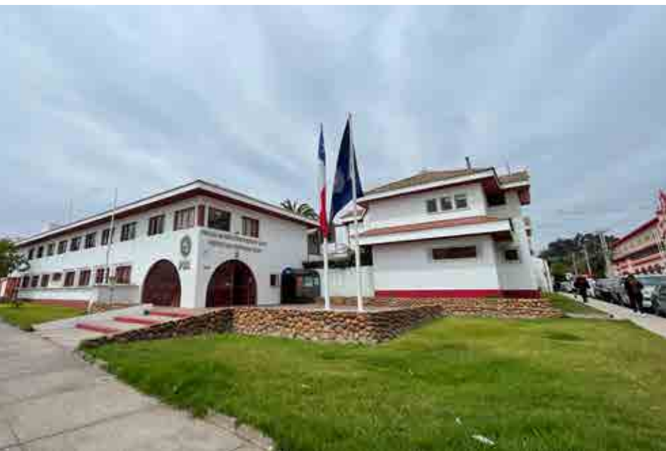
Edificio Cuartel Central PDI de La Serena
