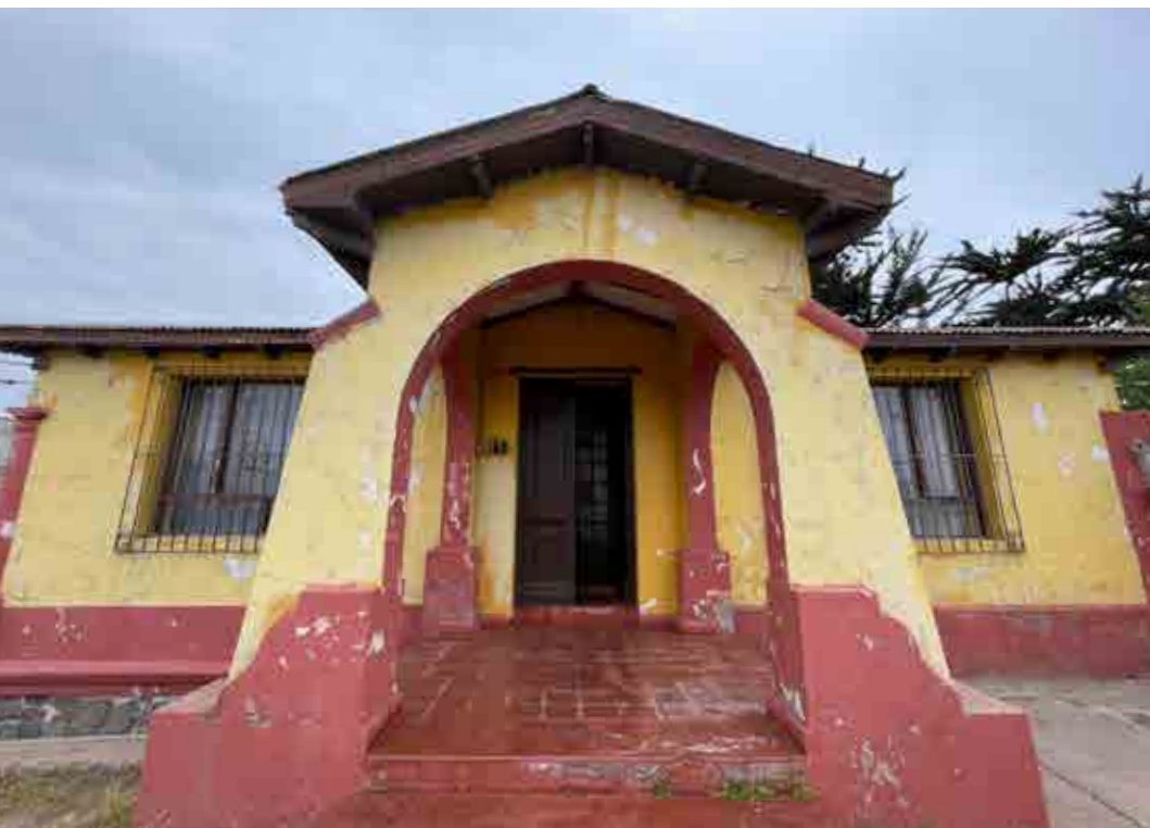
Frontis Casa de Piedra
