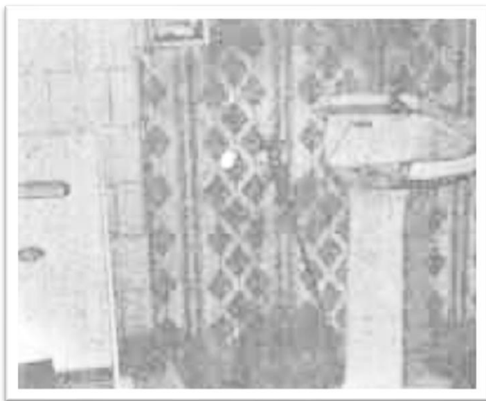
Imagen de los destrozos en el baño de la casa de Daniel Acuña Sepúlveda.
